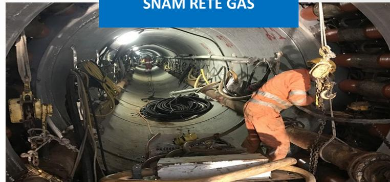
Realizzazione di Direct Pipe e Microtunnel (*Cervignano – Mortara*)
