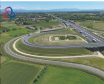
Ampliamento A4 – San Donà di Piave – Portogruaro
